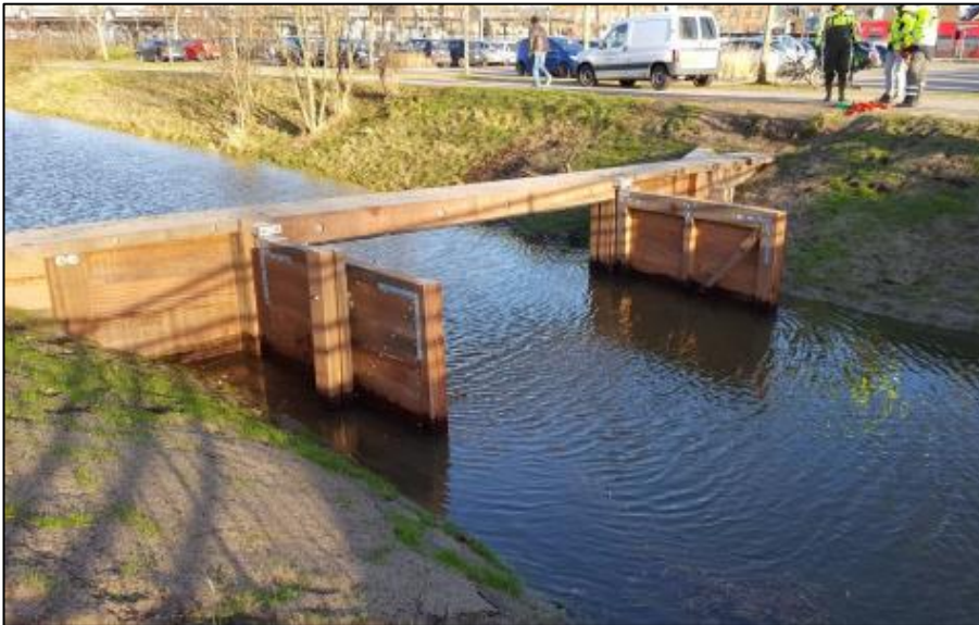
Figur 1: Sluse med sidehængsling
